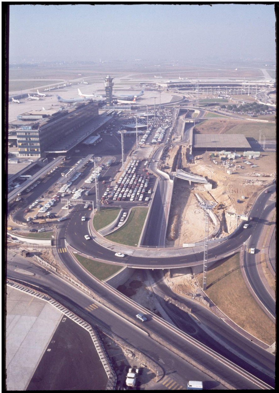
1972, construction du parking souterrain P4 vue depuis l'est.
