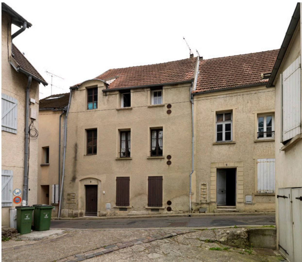
Maison de bourg, 6 rue des Tanneries. La façade sur rue.
