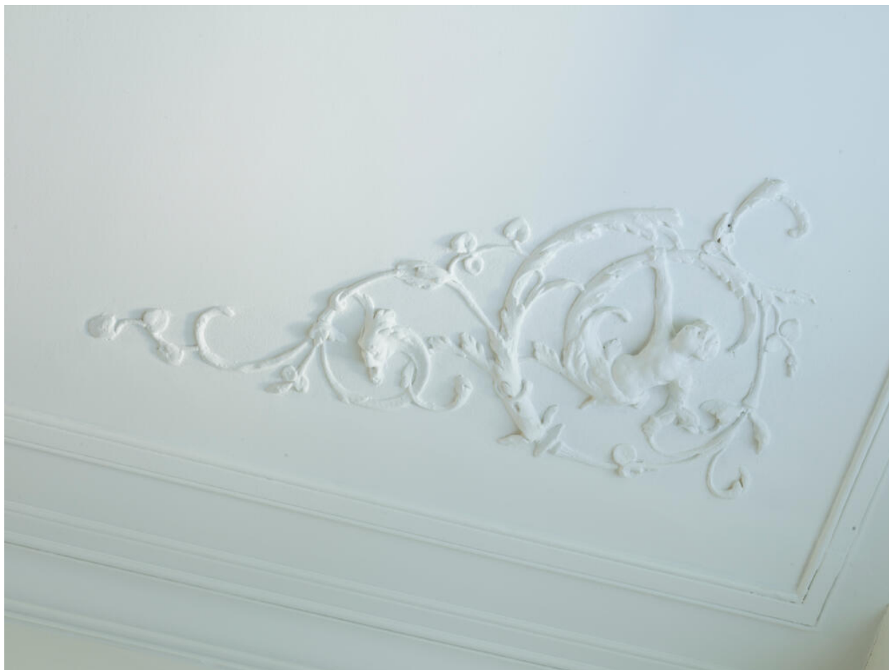
Moulure d'angle du plafond du grand couloir du rez-de-chaussée desservant l'escalier.
