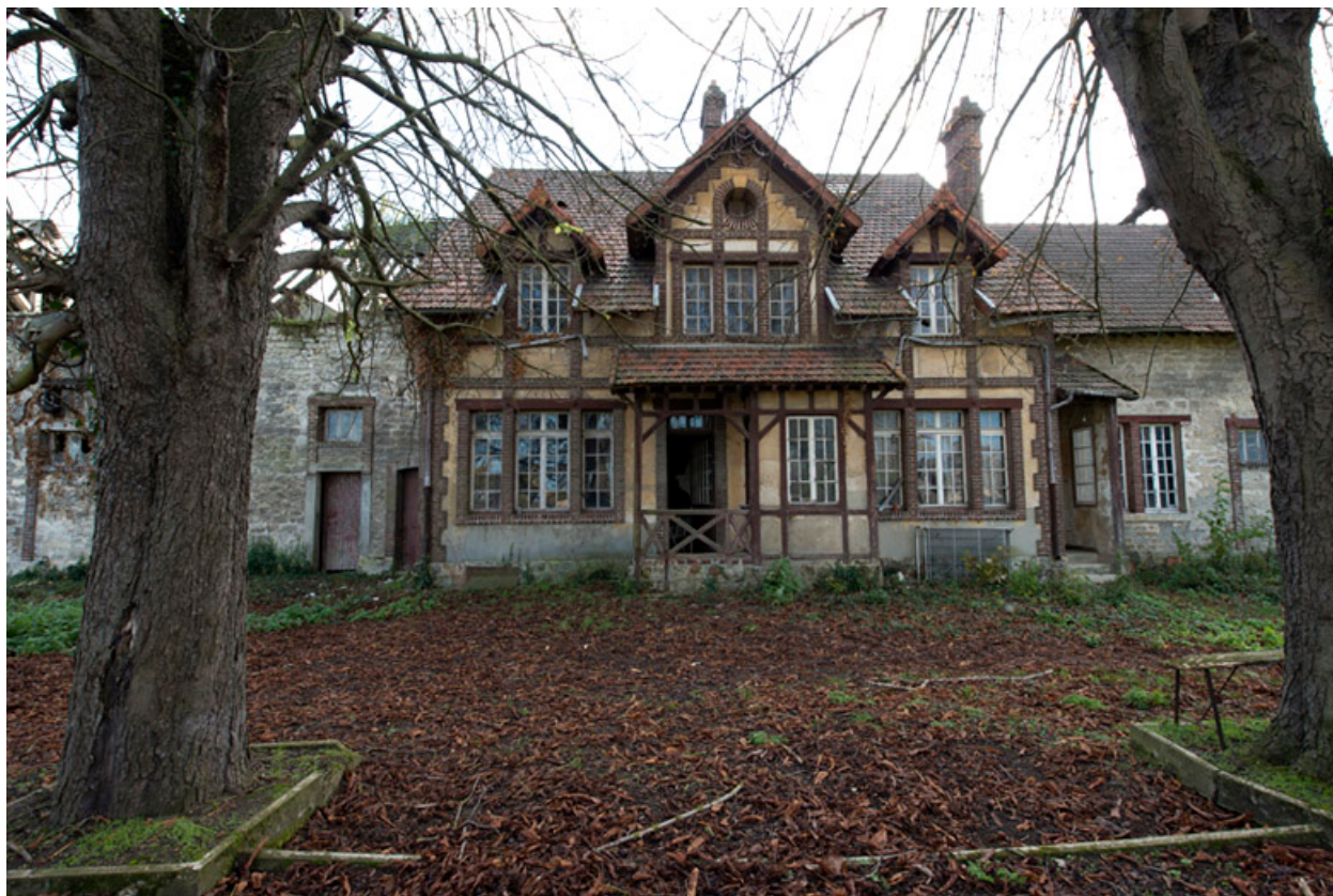
le logis du fermier : la façade.
