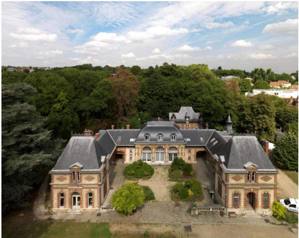
Les communs : vue d'ensemble.
