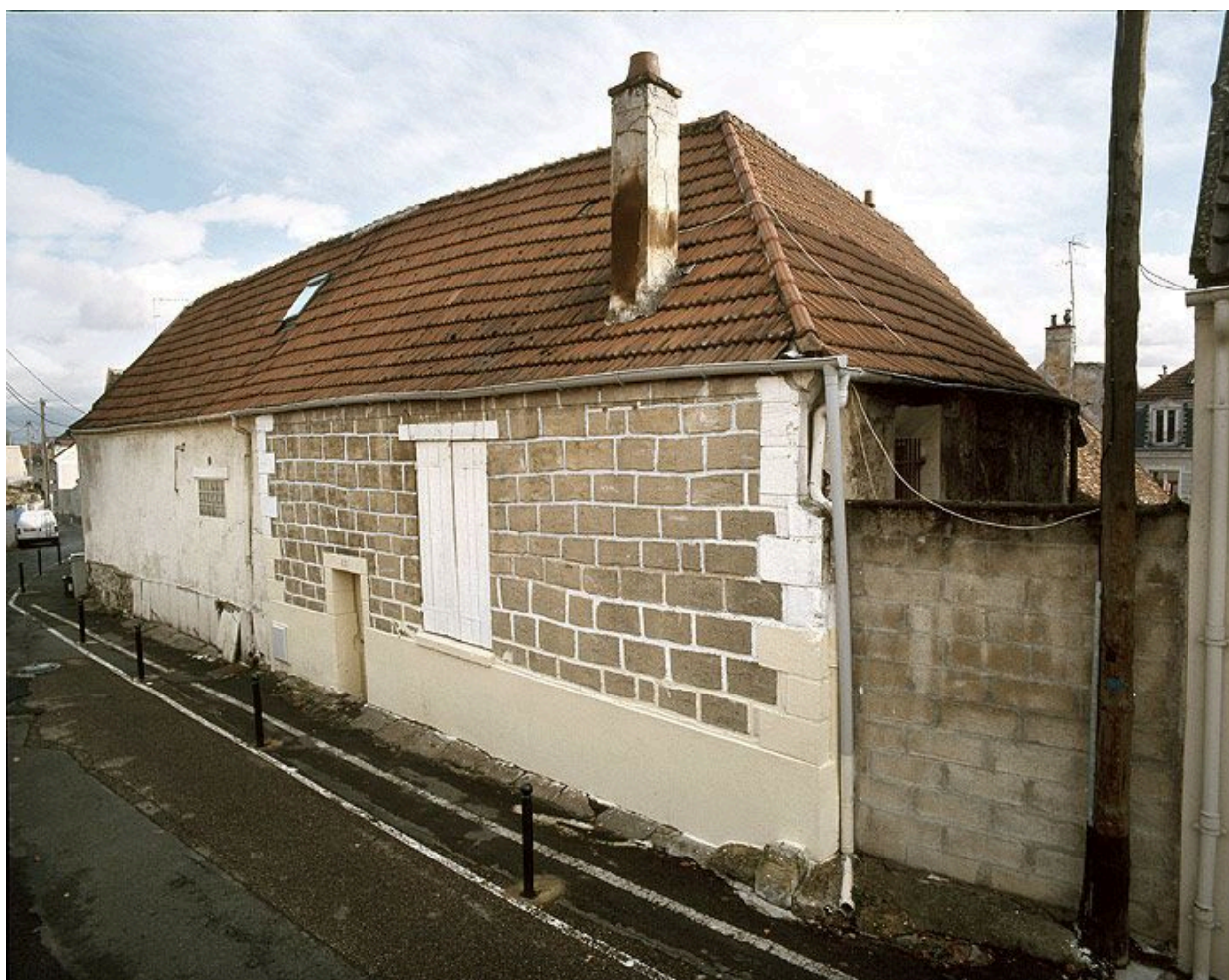
Façade arrière sur la rue de Courcieux.
