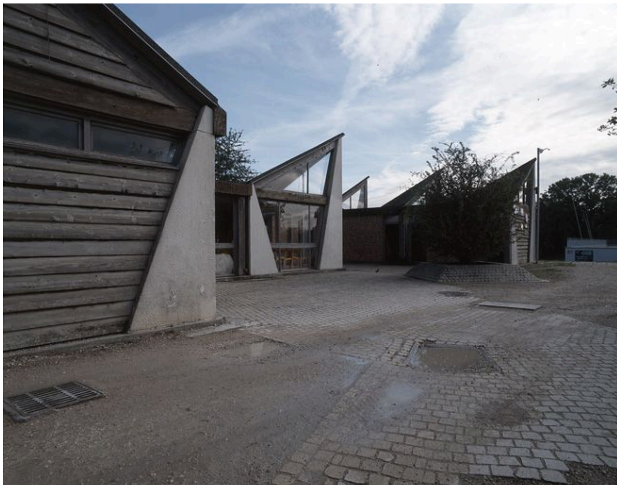
Les bâtiments situés entre le port de plaisance et l'étang Laveyssière.
