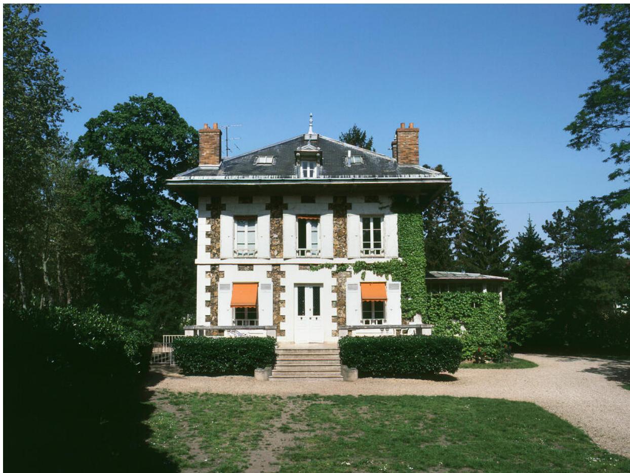
Vue d'ensemble, façade antérieure.
