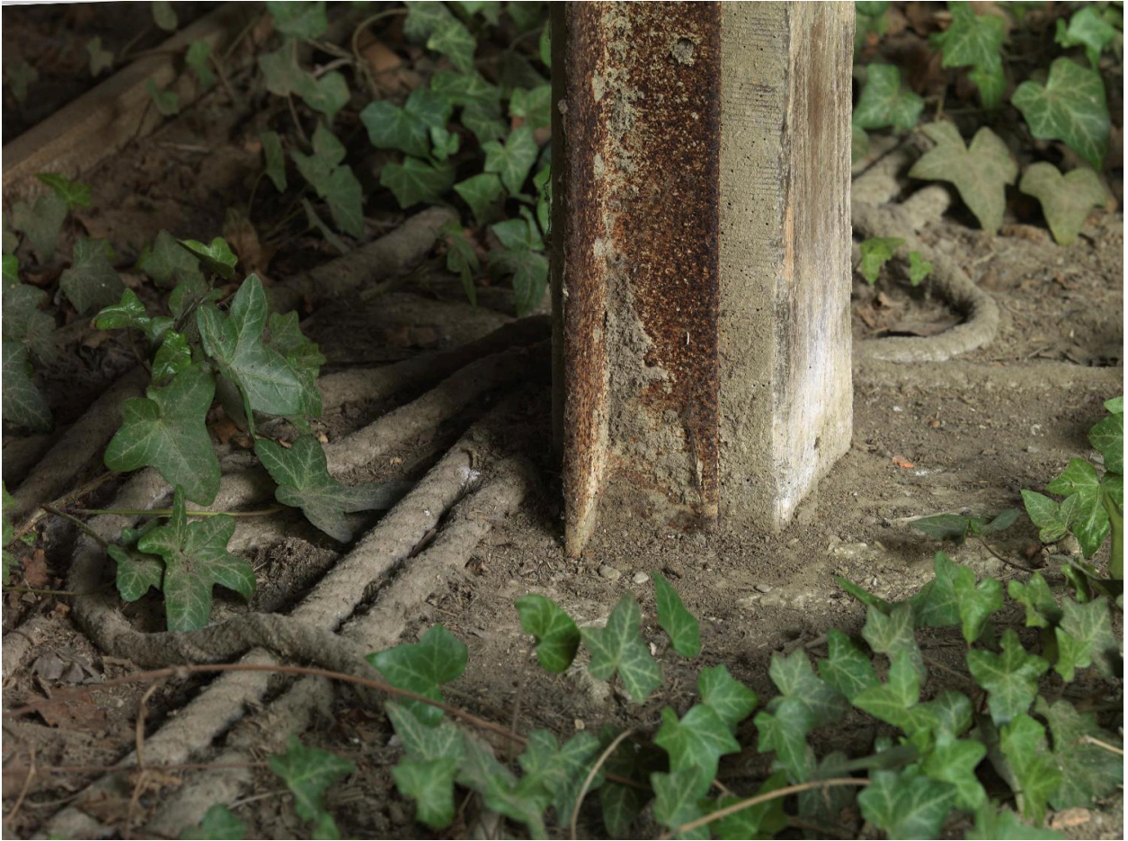
Vestiges de corde au sol.
