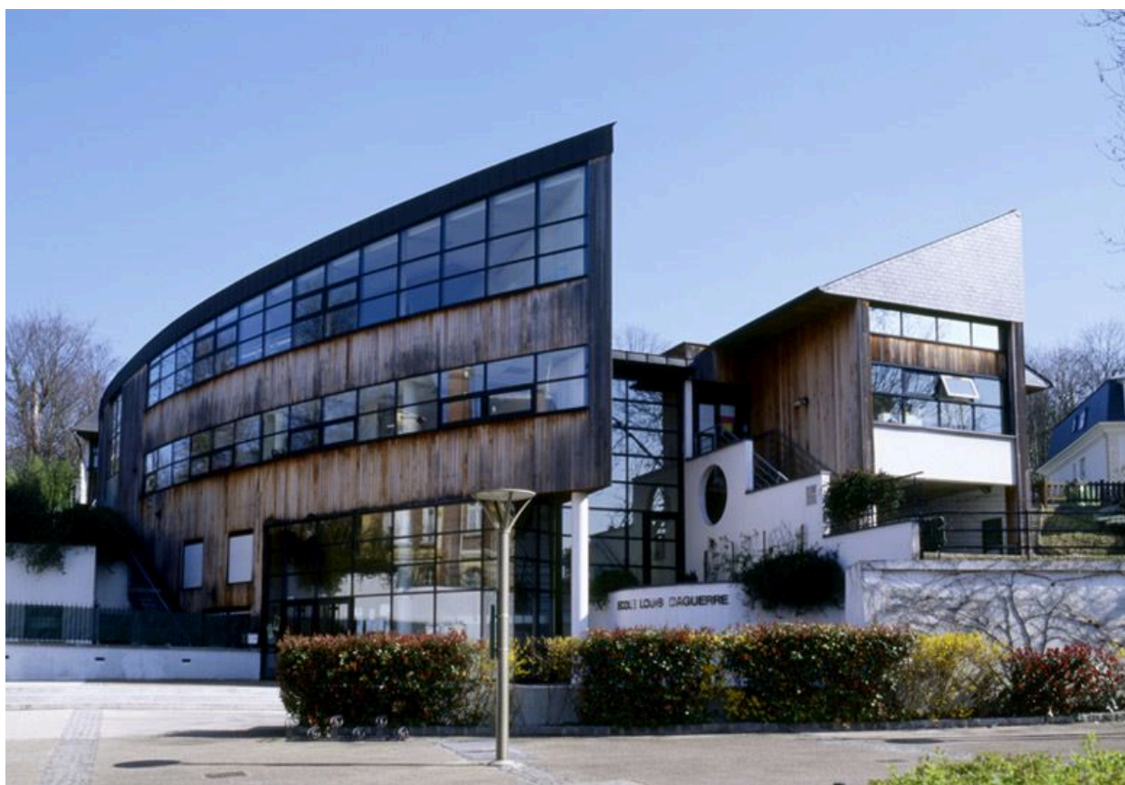
Groupe scolaire Louis Daguerre, rue Louis Daguerre. Vue rapprochée d'ensemble de l'école depuis la rue ; bâtiment ouvert en 1996 et construit par l'atelier 2A+. Gilles Lefebure et Jean-Louis Quertinmont (architectes).
