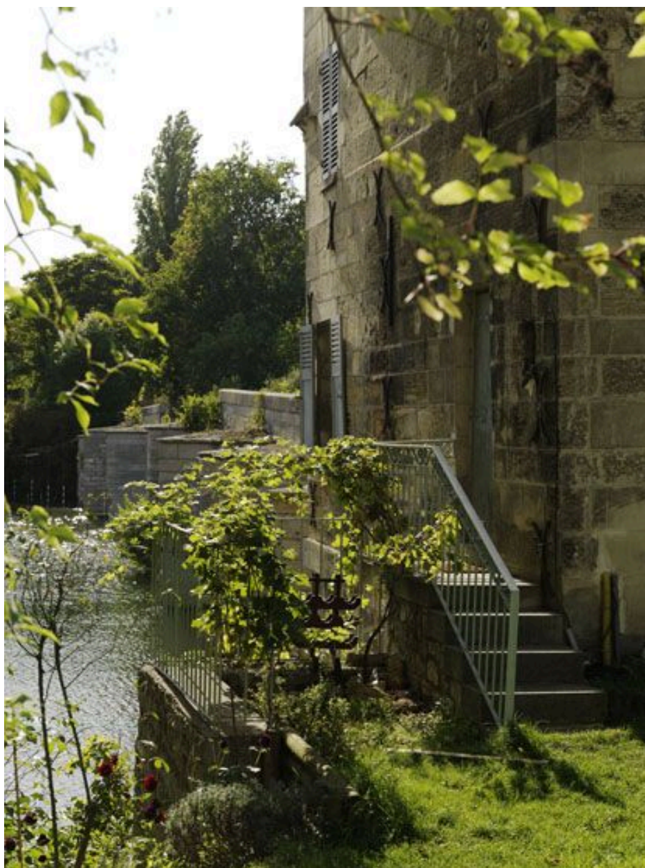
Pignon et jardin de la maison du passeur du vieux mont de Limay vu depuis les quais vers l'aval.
