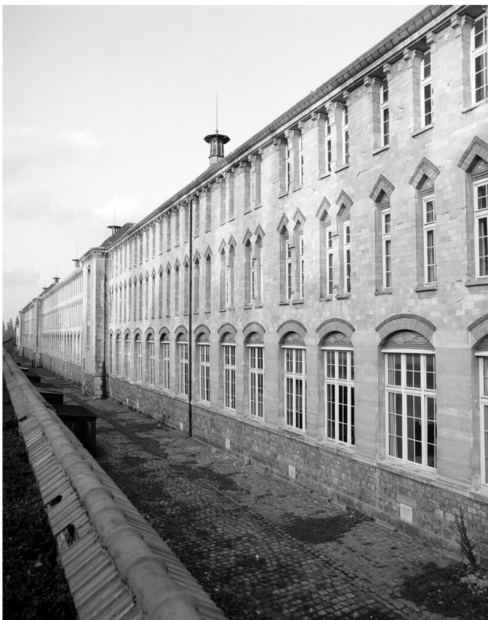
Vue en perspective de la façade ouest. Lycée dit Lycée Lakanal
