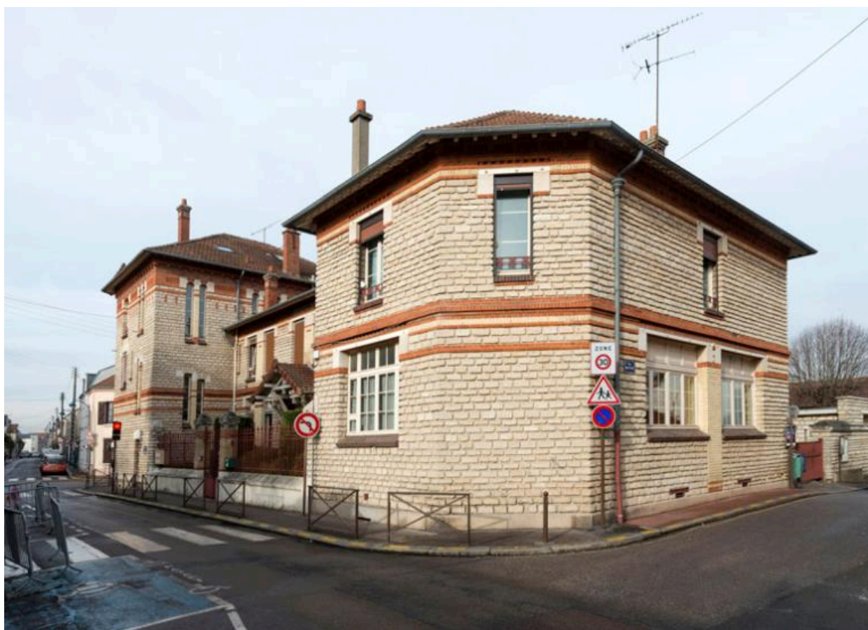
Vue d'ensemble de la façade rue des Écoles.
