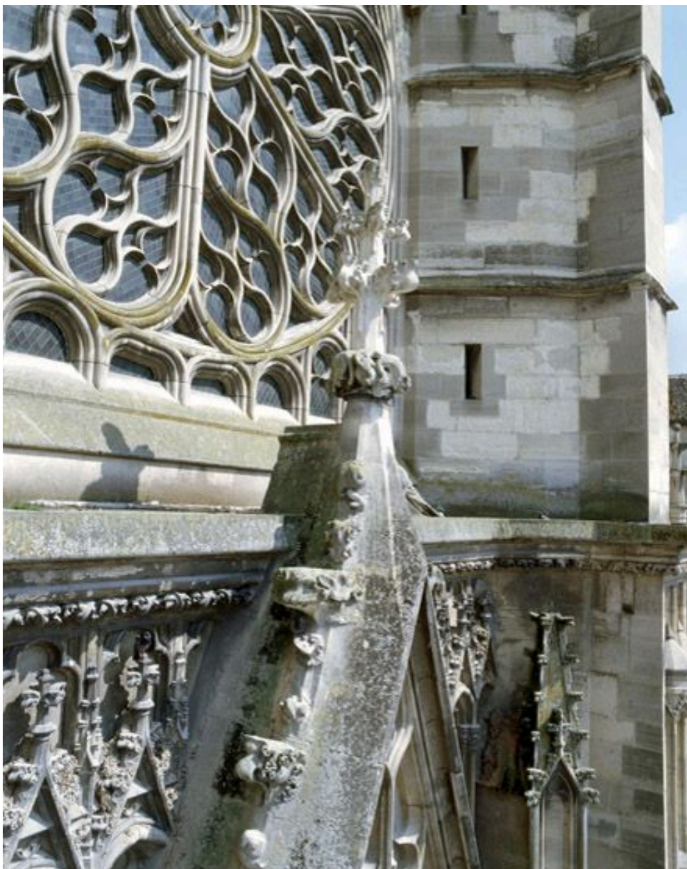
La façade occidentale : détail du gâble du portail central et du bas de la rose, vus depuis l'échafaudage dressé pour la restauration de la base de la tour nord (2008).
