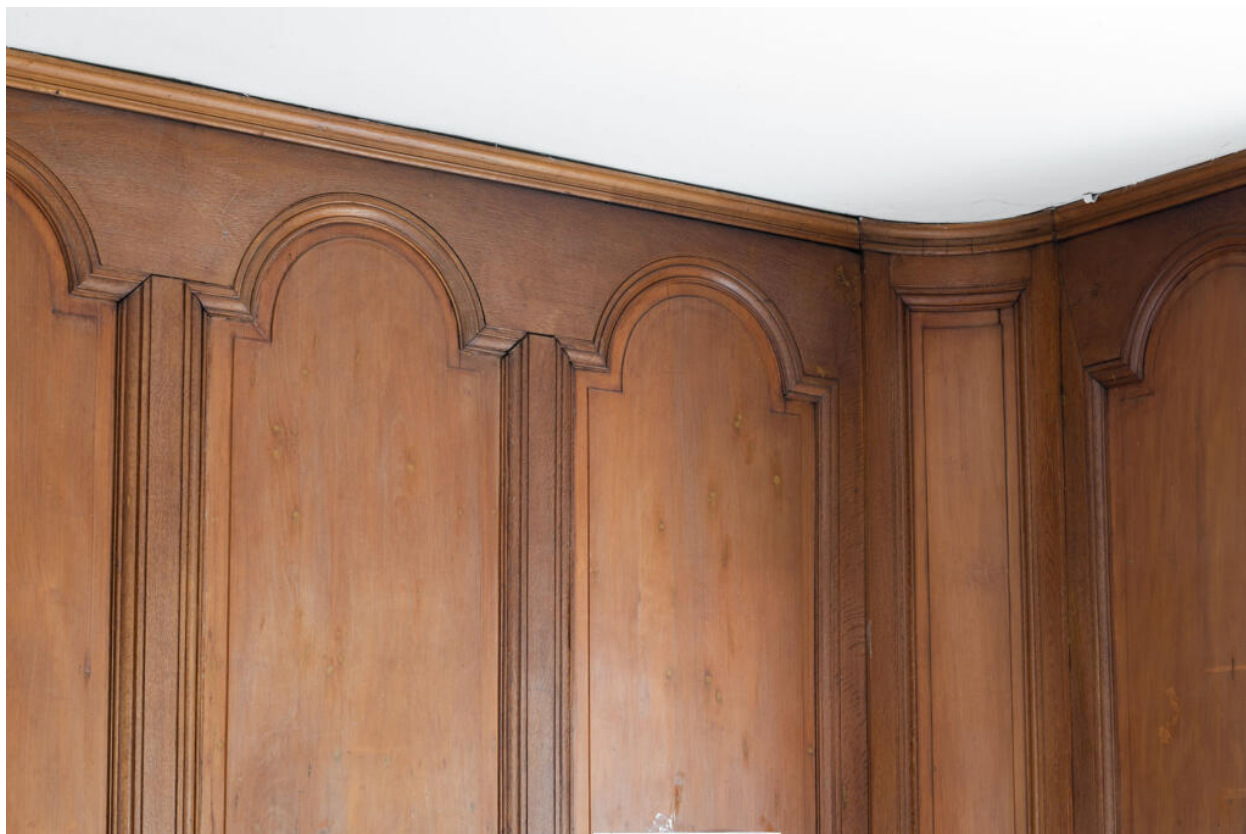
La salle à manger, détail des boiseries.
