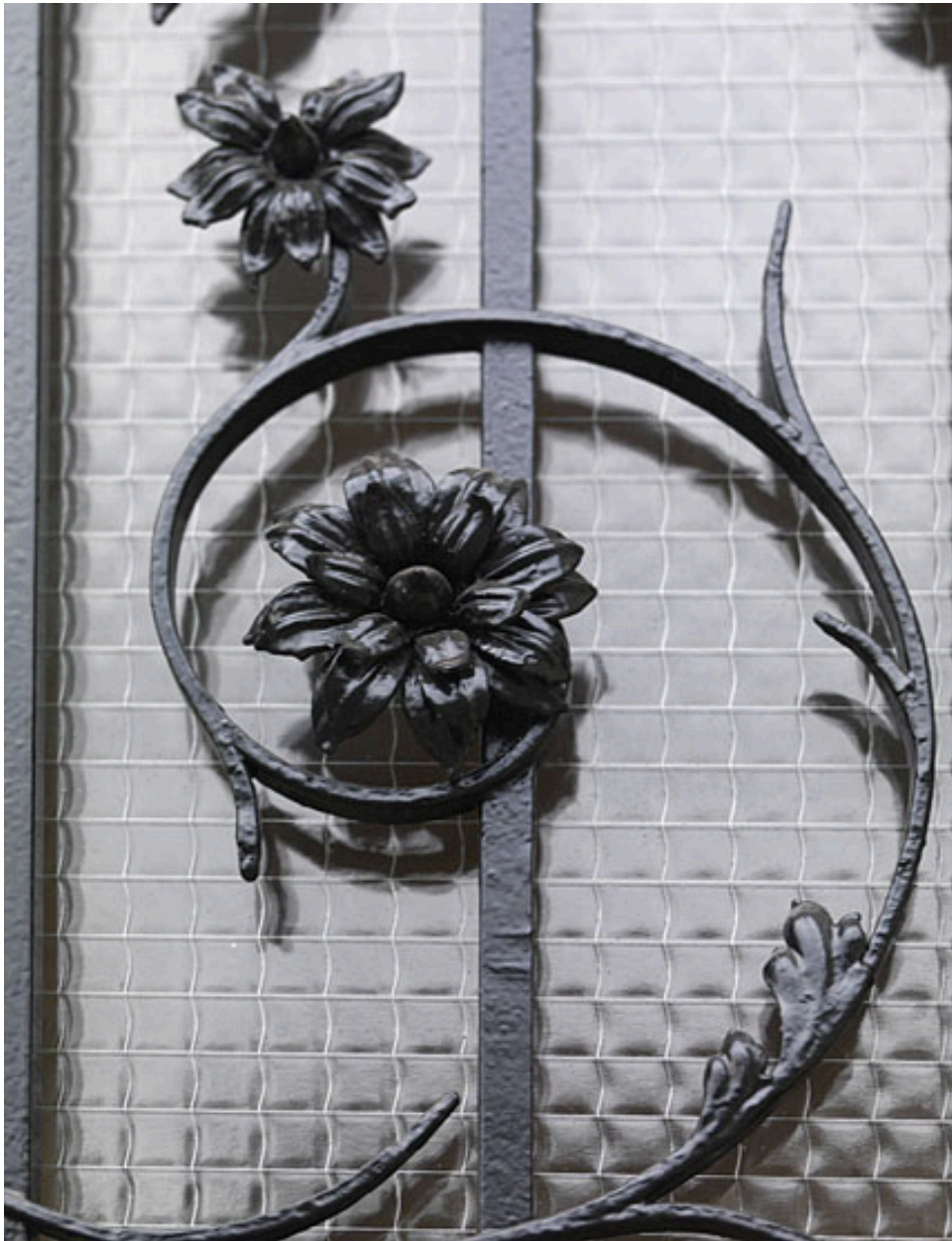
Détail d'une volute fleurie de la porte d'entrée de l'immeuble : travail de ferronnerie d'art, 1926.
