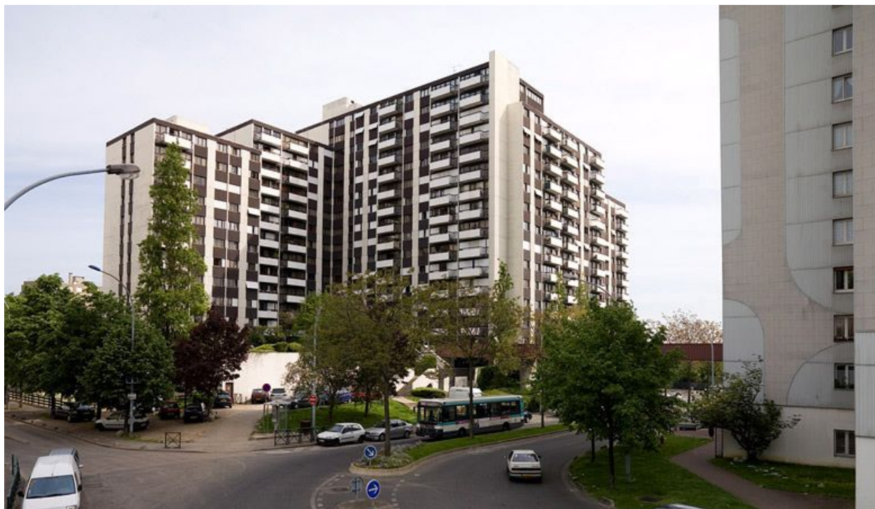
Choisy-le-Roi, secteur urbain concerté dit dalle du centre-ville. L'ensemble de logements Les rives de la Seine.
