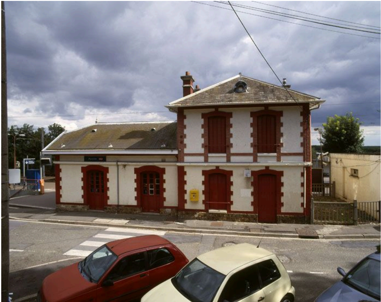
La halte de Maurecourt : vue de la façade sur rue.
