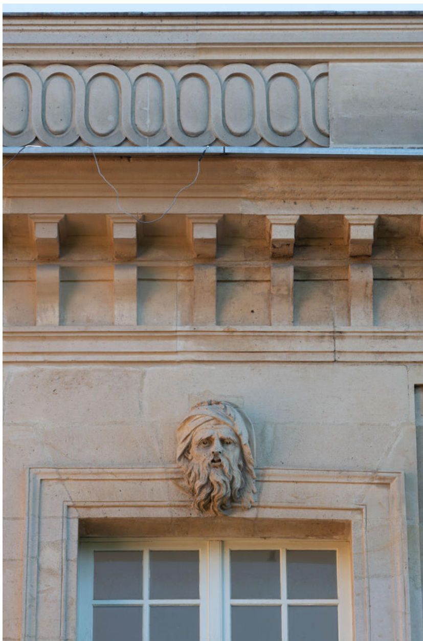
Façade sud, premier étage : 1ère fenêtre depuis l'extrémité est, antichambre de Madame. Les agrafes représentent les quatre saisons. Ici, l'hiver.
