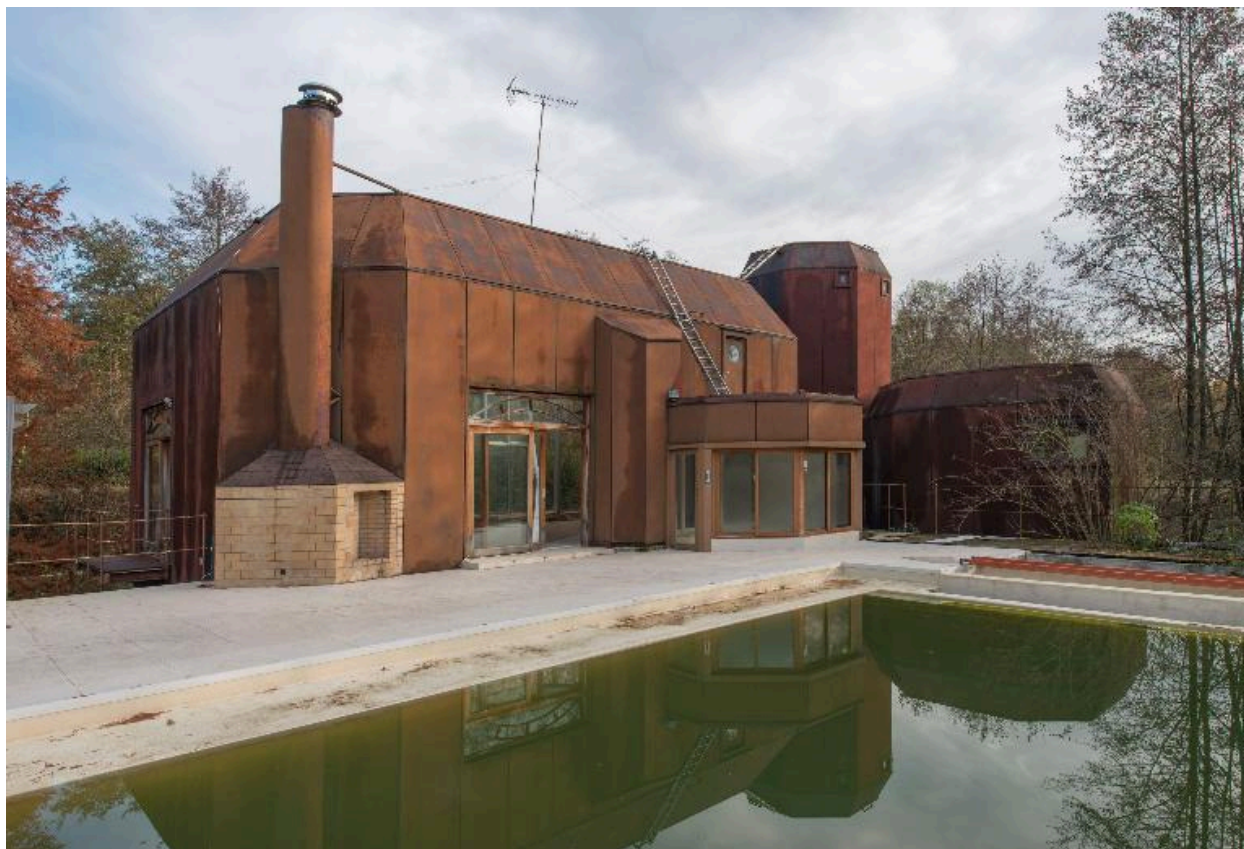
Vue rapprochée de la façade sud
