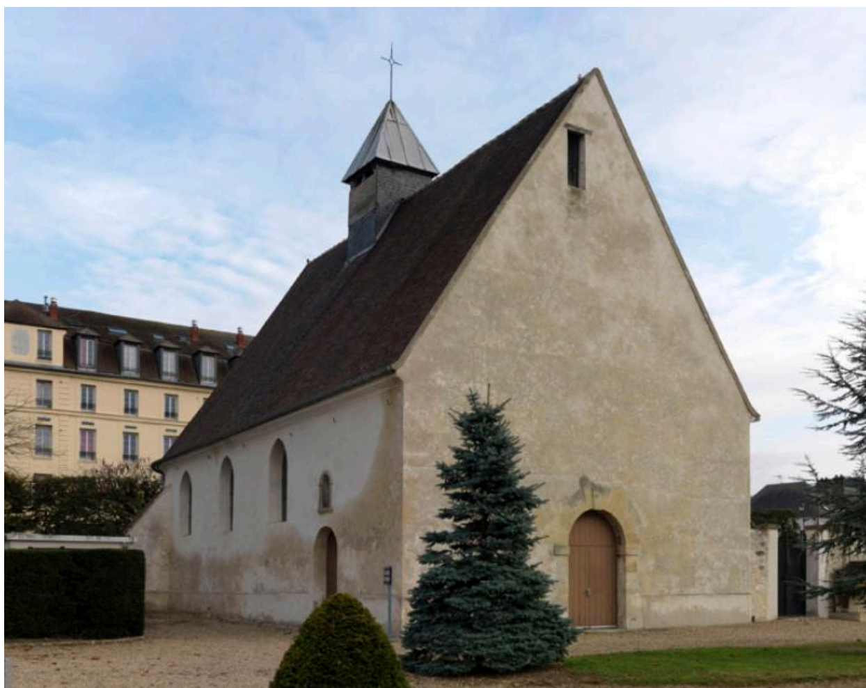
Vue d'ensemble de la chapelle depuis le cimetière.
