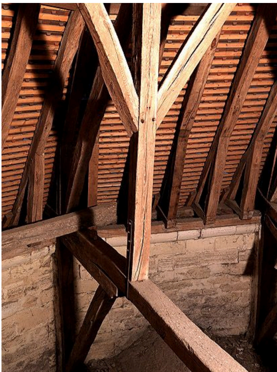
Détail de la charpente de l'abside : demi-ferme d'arêtier.
