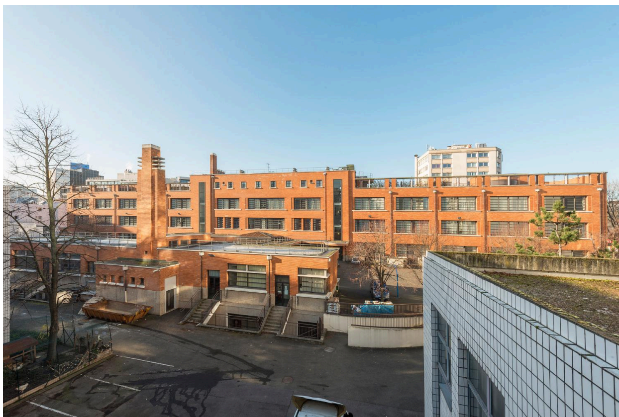
Vue générale de la façade postérieure du lycée, sur cour.
