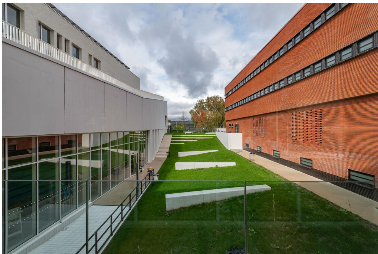
Piscine Alice Milliat. Extension à gauche et bâtiment historique à droite.
