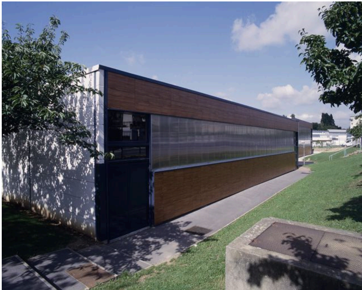
Vue perspective de la façade latérale de la salle omnisports avec bardage de bois et vitrage horizontal continu.
