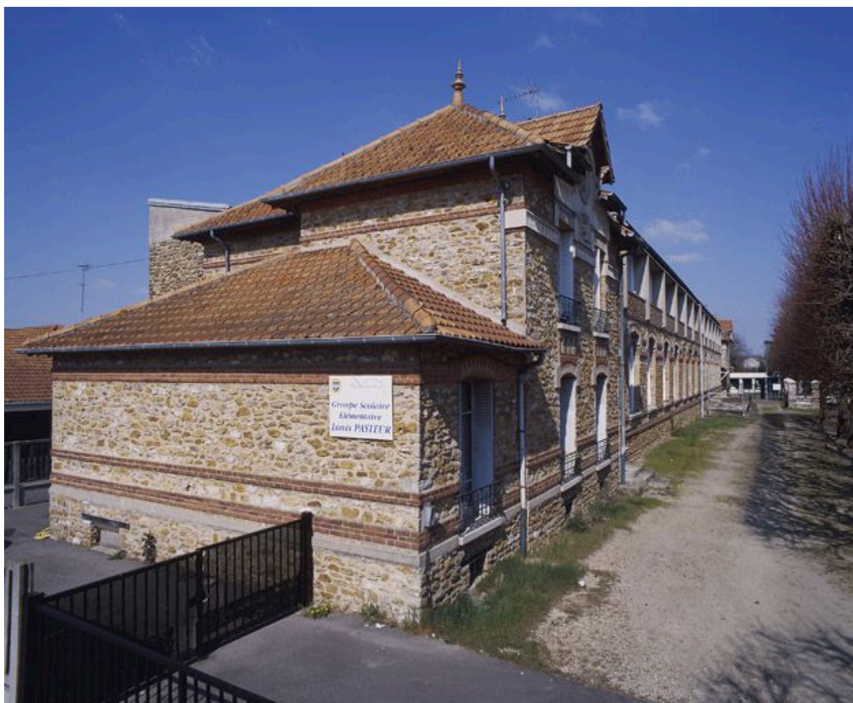
Vue d'ensemble, à partir de la façade latérale ouest.
