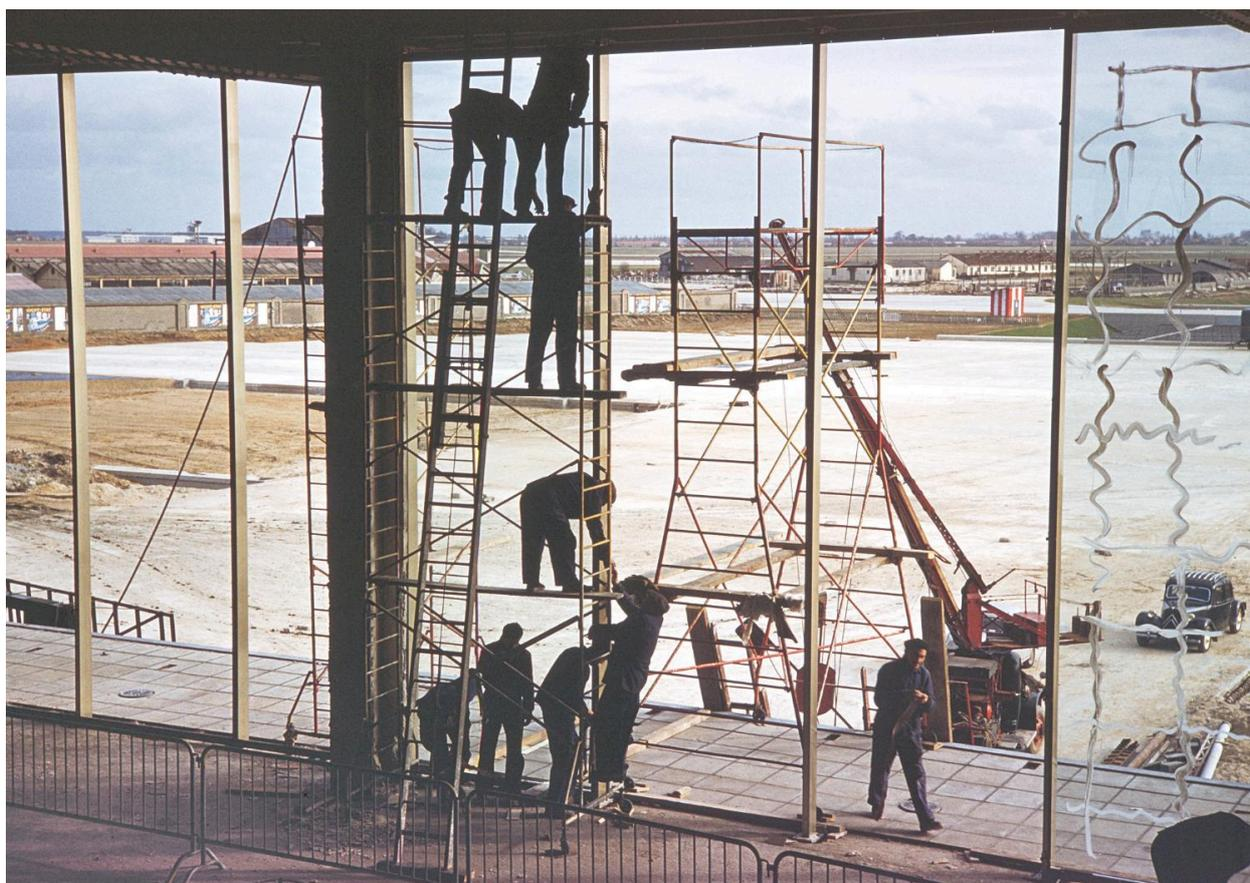
1957 1961, la construction des Installations Terminales: l'installation des dalles en verre du mur-rideau de la façade sud, vue prise depuis la future Galerie Marchande au 1er étage.
