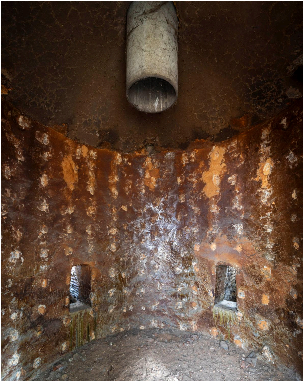
Intérieur du four rond à globe et à flamme renversée.
