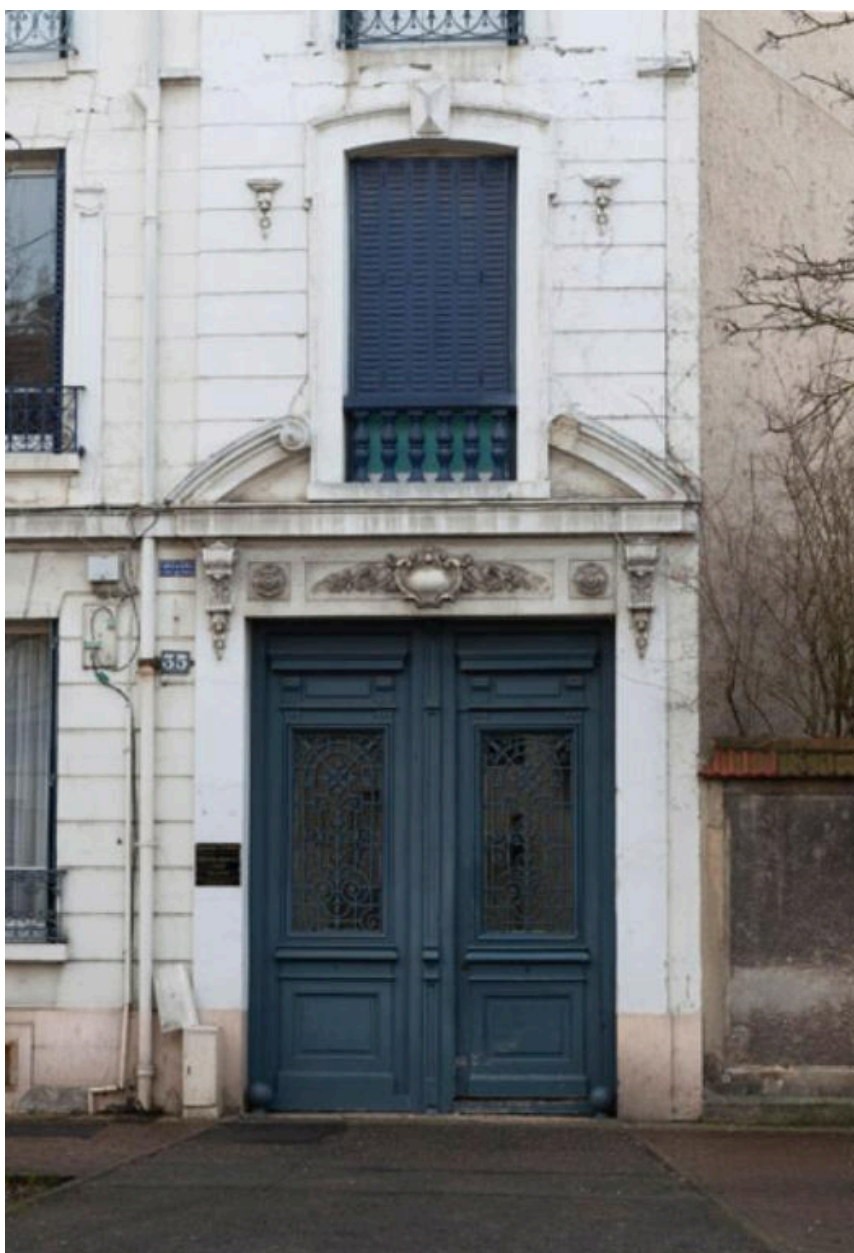
La porte cochère de l'immeuble du 35 avenue du Président Roosevelt.
