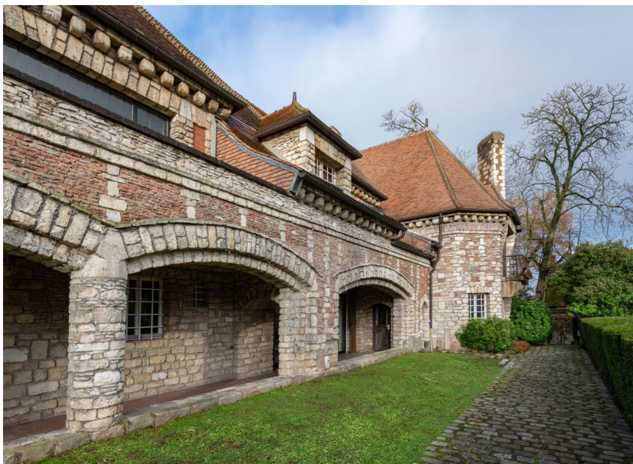
Villa des Tourneroches, galerie couverte au rez-de-chaussée de la façade orientale
