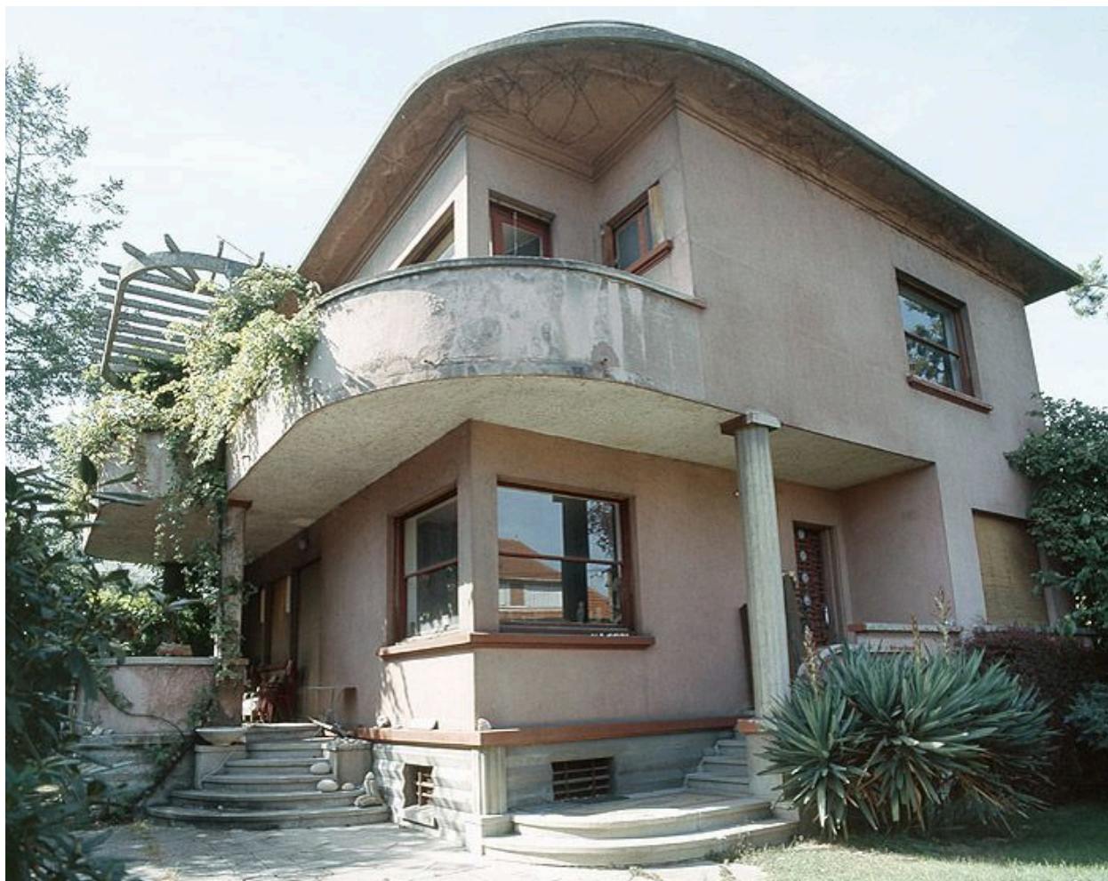
Maison, 47 rue de la Gaîté.
