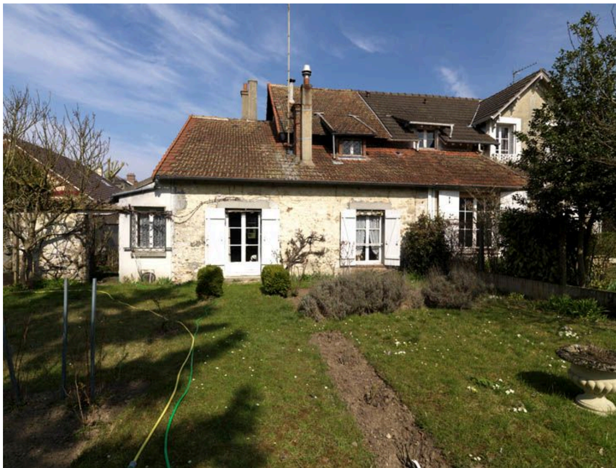
Façade arrière, extension postérieure à la construction de l'atelier.
