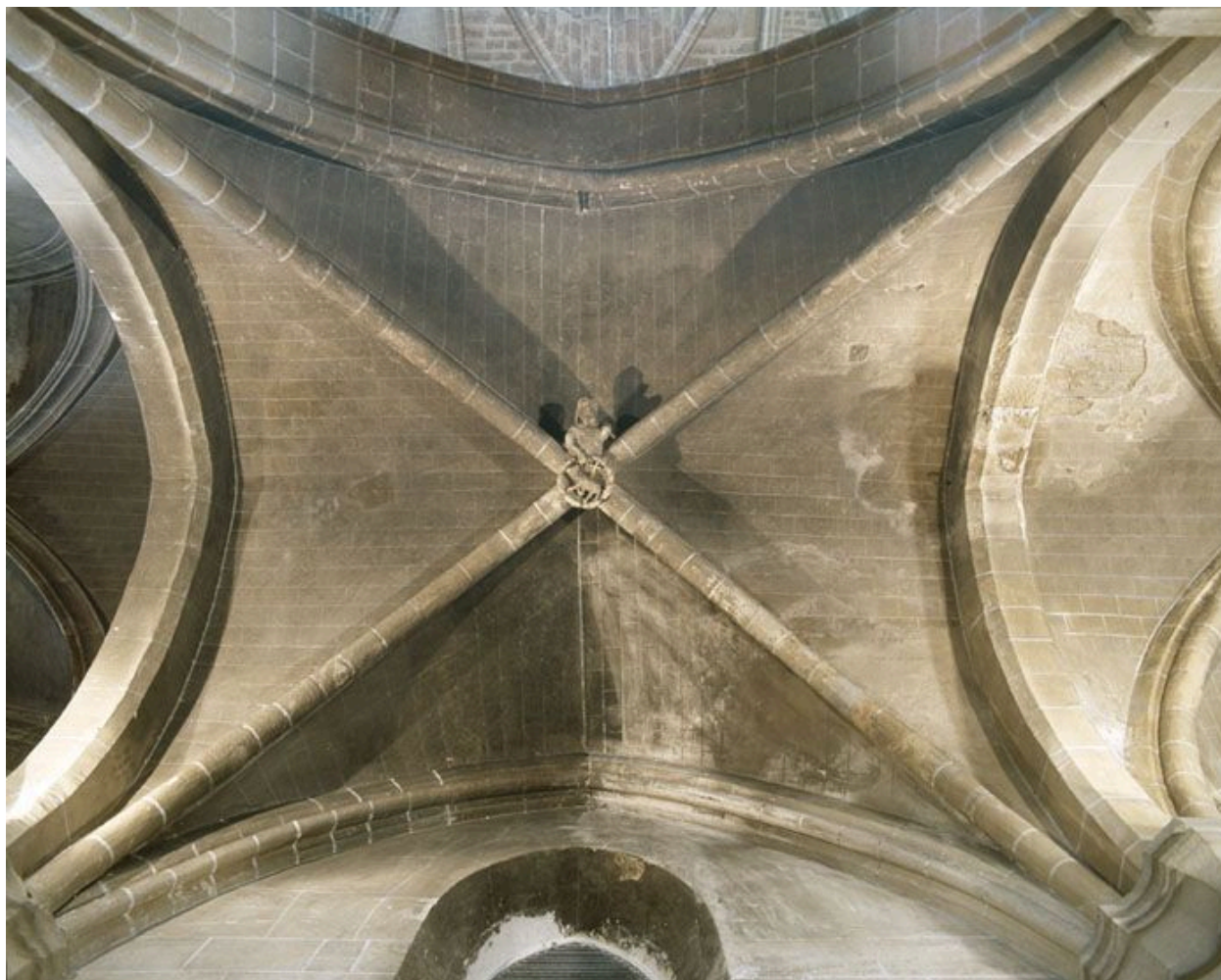
Voûte sur croisée d'ogives de la première travée du bas-côté sud.
