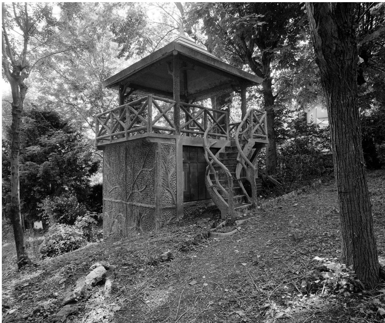
Vue du kiosque de jardin en ciment imitant le bois écoté.
