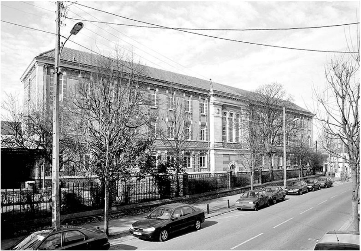
Le ""Petit Quartier"" (n° 6 sur le plan) : la façade vers la rue du Général-de-Gaulle.
