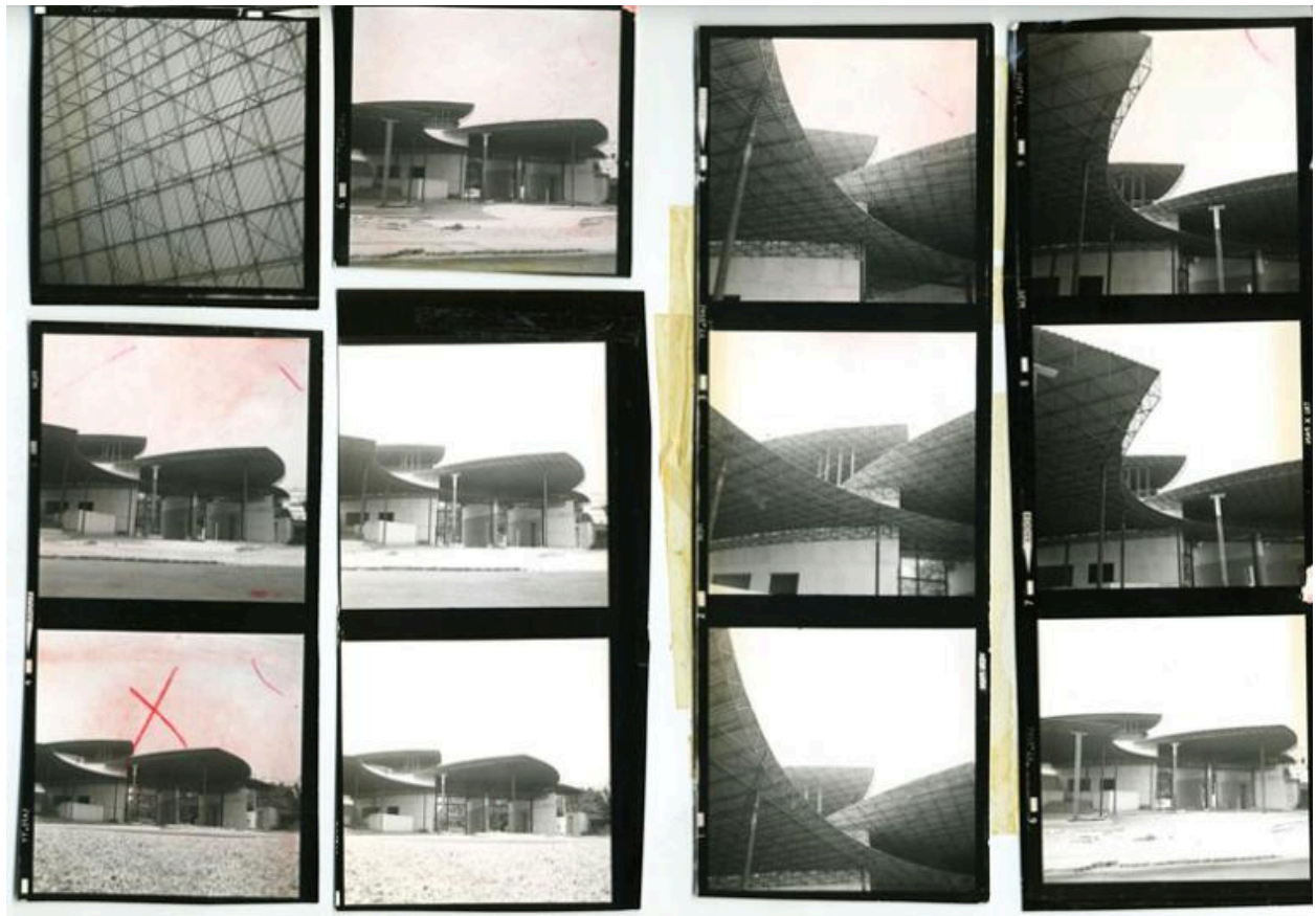
Planches-contacts de vues de la station-service en construction.
