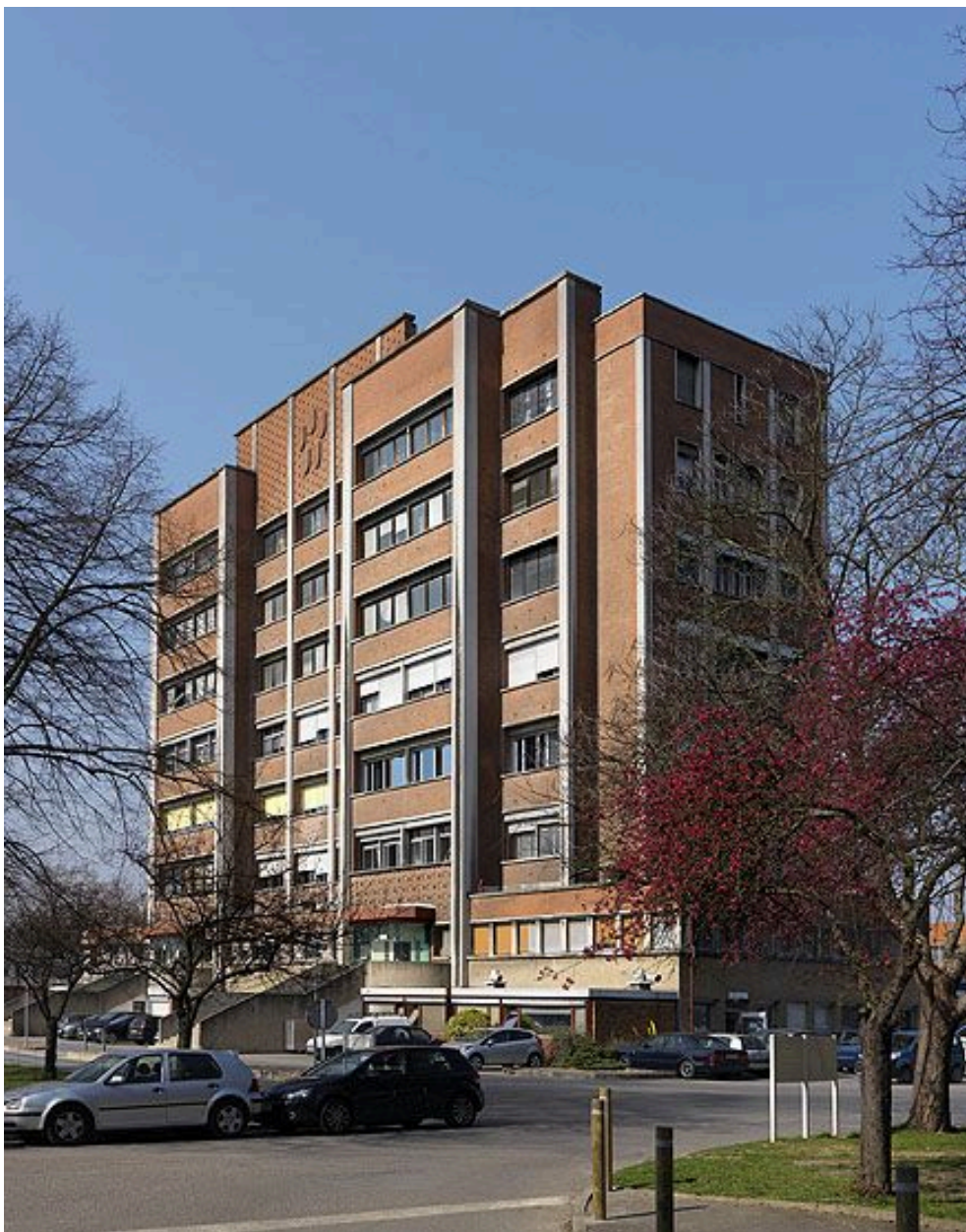
93, Villepinte, hôpital Robert-Ballenger, boulevard Robert-Ballenger . Vue générale du profil nord-est de l'hôpital.
