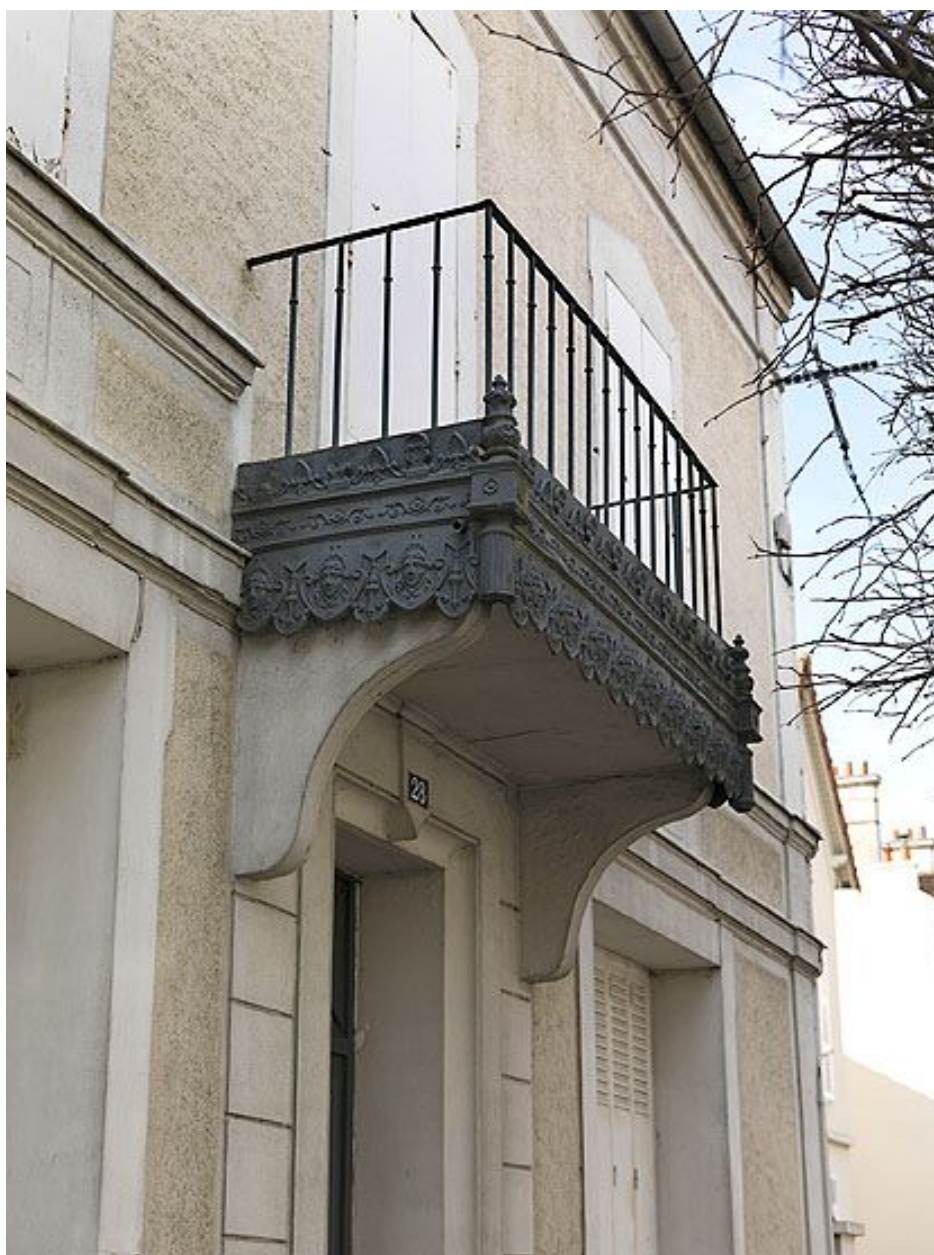
Maison 28 avenue de la République : détail du balcon en fonte.
