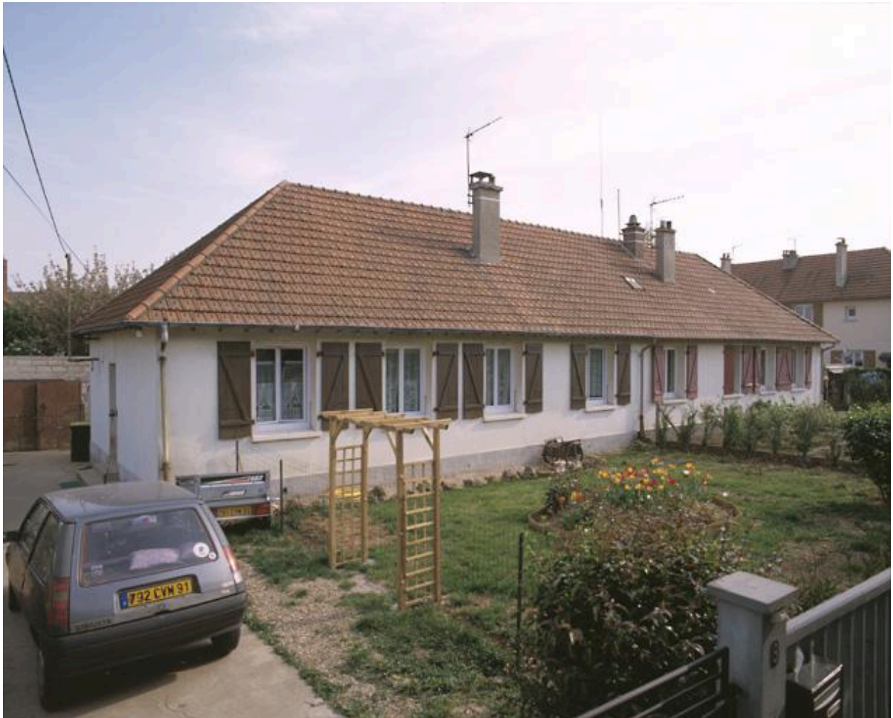
Vue d'ensemble de deux maisons jumelles en rez-de-chaussée, situées aux numéros 9 et 11 avenue Léon-Blum.
