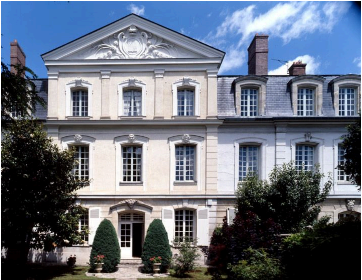
Détail de l'aile sud, construite en 1740.
