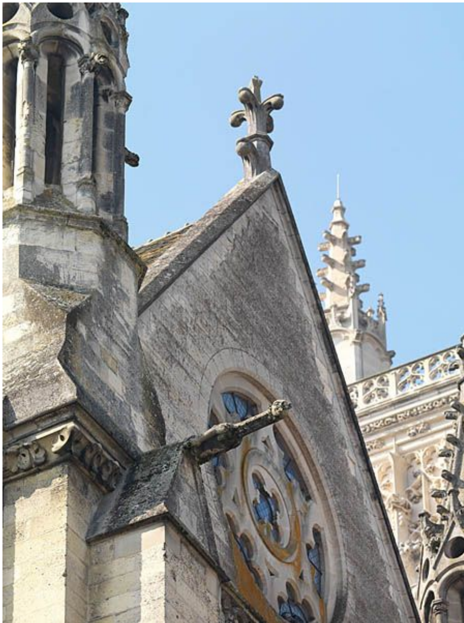
Détail du pignon du transept nord.
