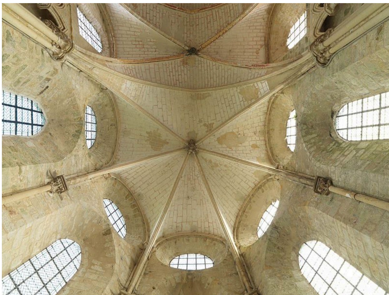
Détail de la voûte de l'abside.
