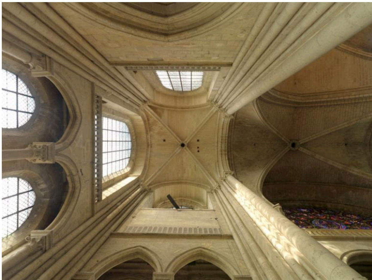
La salle haute sous la tour sud. Vue en plongée.
