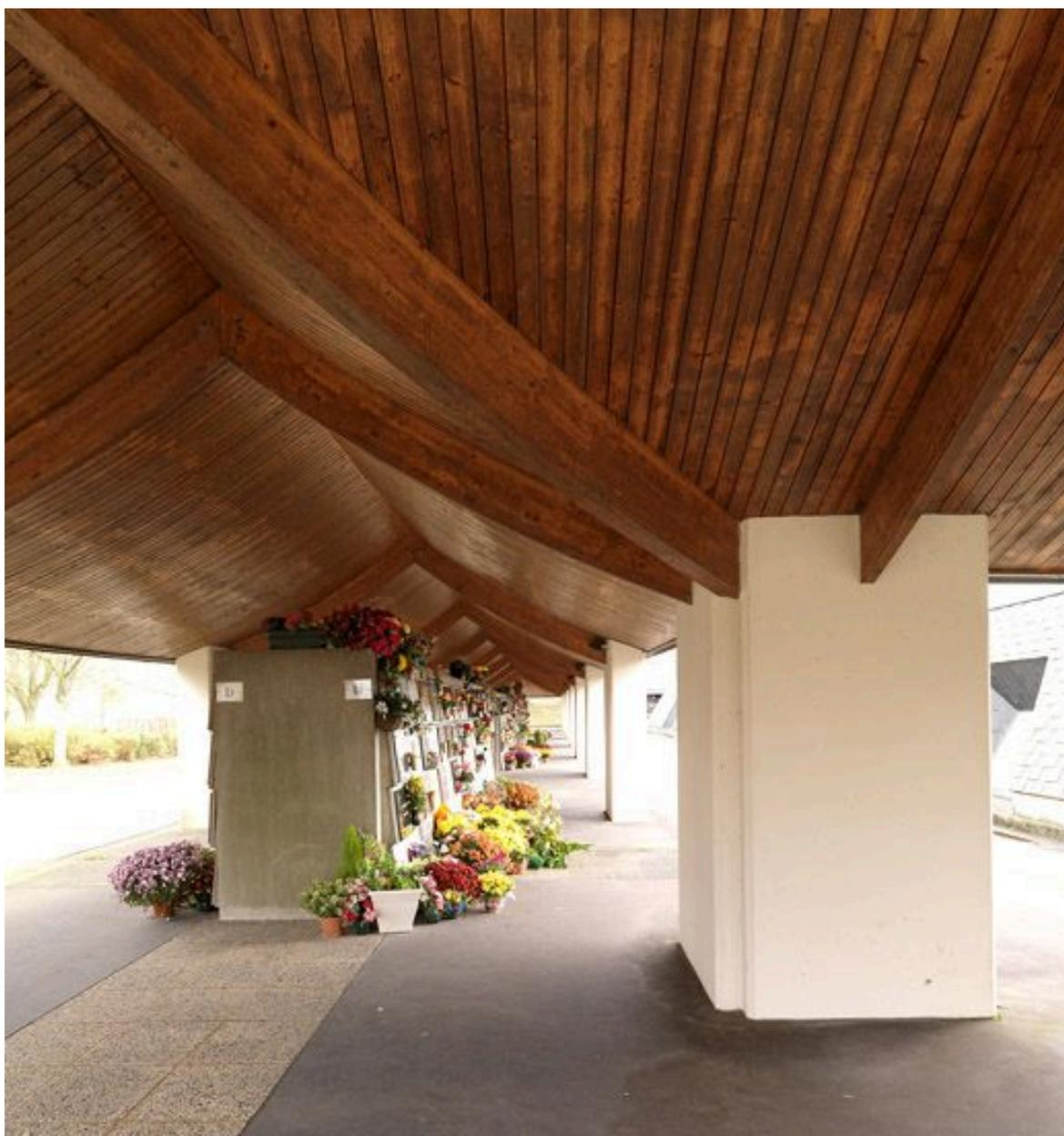
Détail de la sous-face lambrissée de la toiture d'un portique du columbarium.
