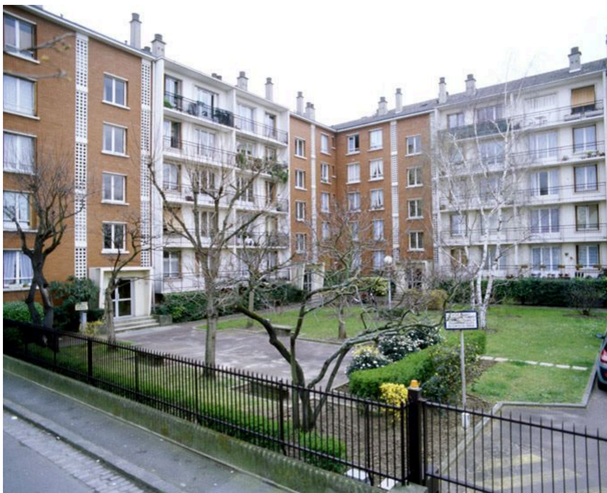
Cité, 112-114 avenue Roger Salengro. Vue d'ensemble depuis le boulevard. Heulot, Julien (architecte communal)
