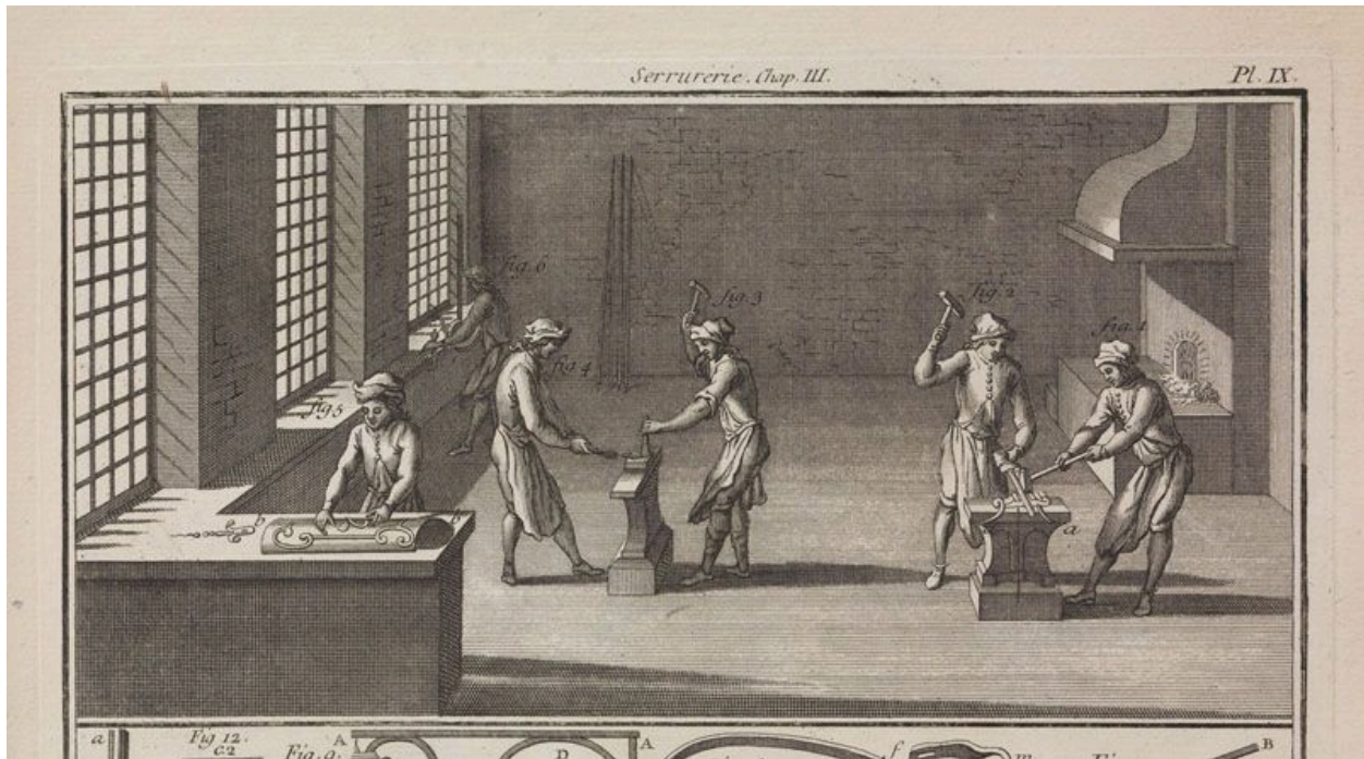
Un atelier de serrurier avec four mural. Gravure, 18e siècle. Tiré de : L'Encyclopédie, Serrurerie-ferronnerie / Diderot et d'Alembert. Réédition, Bibliothèque de l'Image, 2002.
