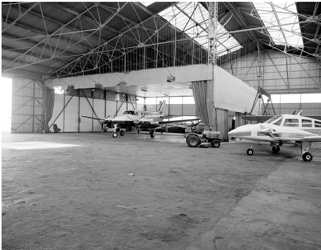
Vue d'ensemble de l'atelier de réparations.
