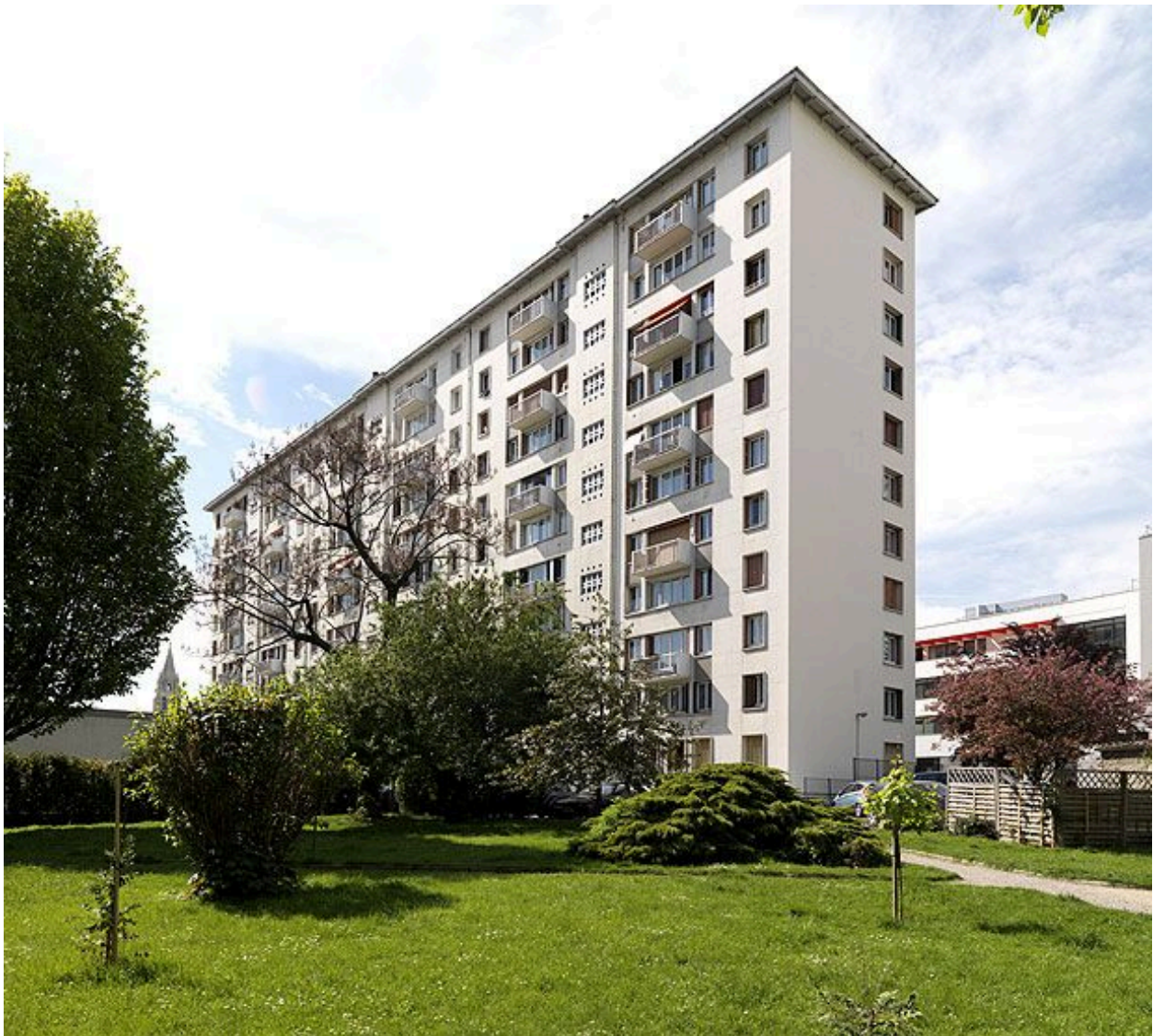
Vitry-sur-Seine, ensemble d'édifices à cour commune, 37 rue Louise-Aglaré-Cretté. Vue d'ensemble du bâtiment conçu par Pingrié.
