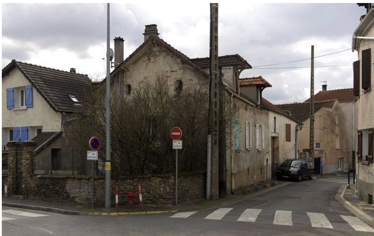
Chanteloup-les-Vignes. Vue d'ensemble d'une maison rurale, 48-50 rue de l'Abreuvoir.
