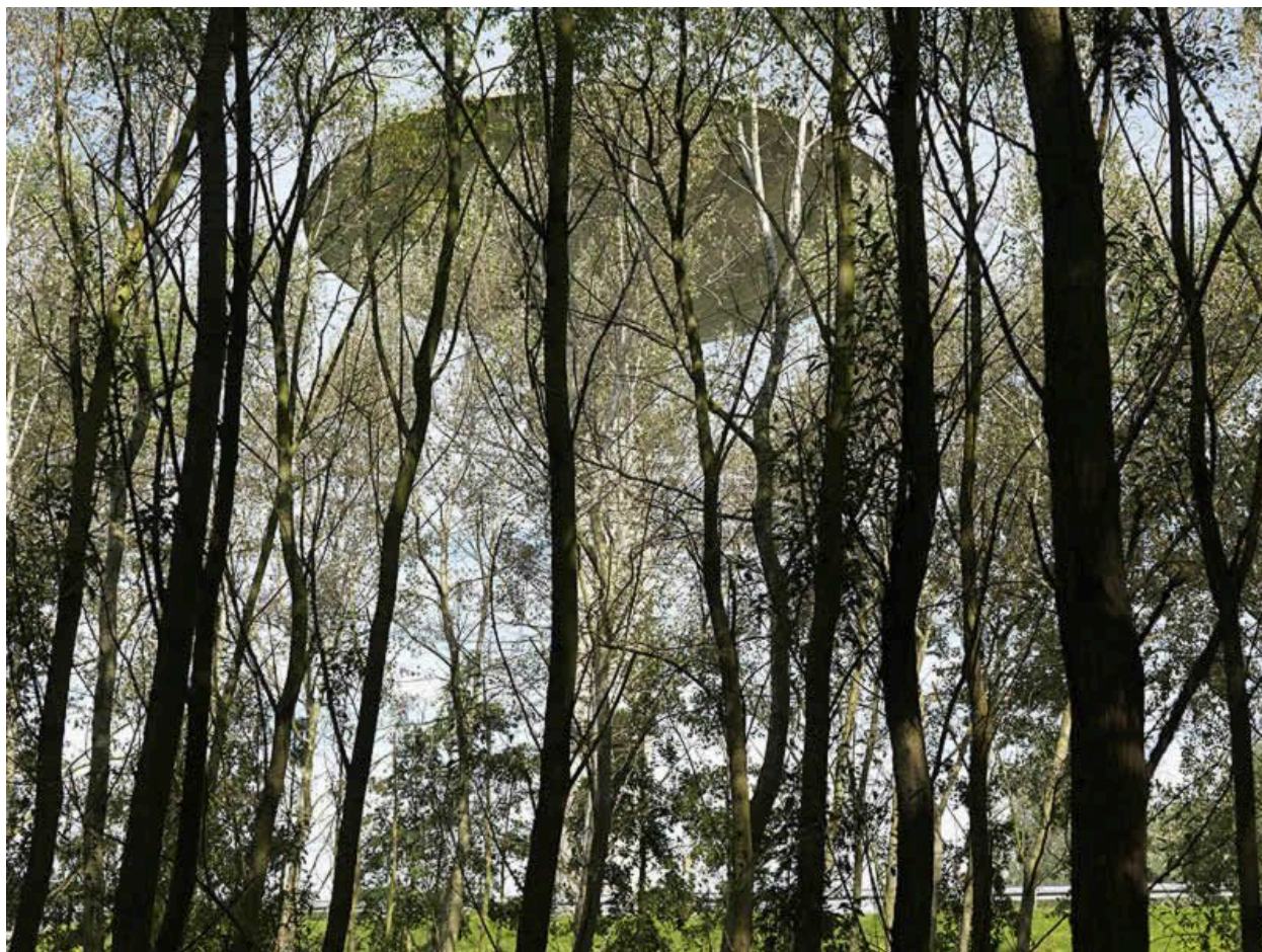
95, Roissy-en-France, rue du Berceau. Château d'eau au milieu de la plateforme aéroportuaire.
